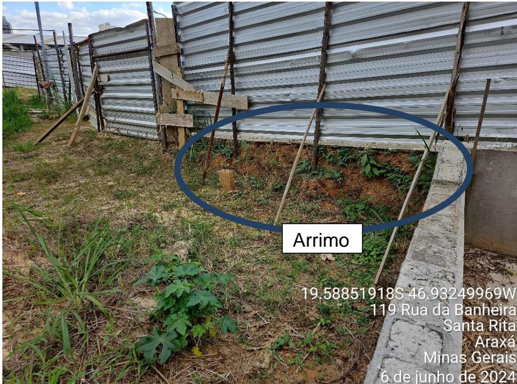
Toda estrutura de arrimo deverá ser executada com blocos de concreto estrutural preenchidos com graute. Em relação a fonte, deve-se demolir a primeira fiada para que a água tenha altura suficiente para queda.
