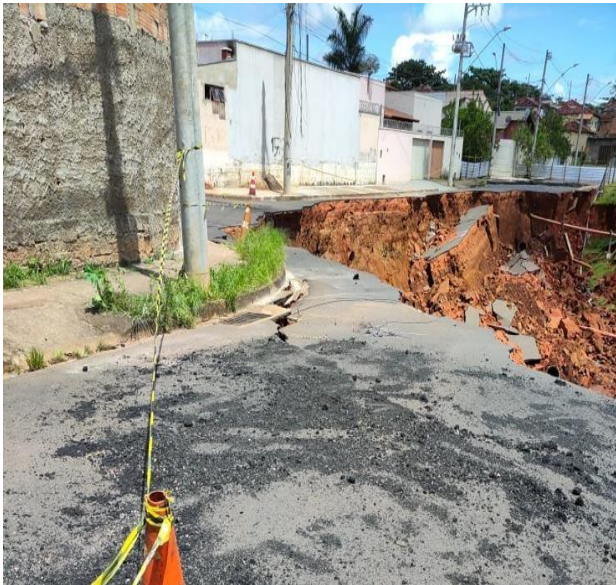
Figura 1-8 - Segunda erosão, se observado, diferente da primeira erosão, o impacto causado nesta foi bem maior se comparada as dimensões e os limites que atingiu, chegando bem próximo aos muros e portões das residências. (Fonte: Consórcio Minas Projetos, 2023)
