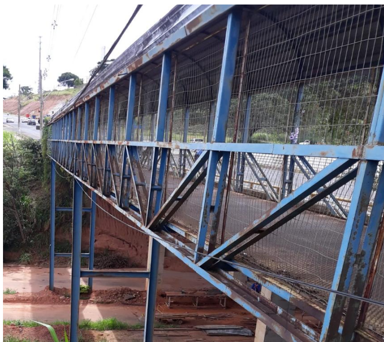
Figura 2: Passarela Existente Para Pedestres Viaduto José D. Filho
