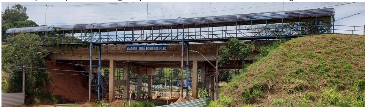
Figura 1: Passarela Existente Para Pedestres Viaduto José D. Filho
