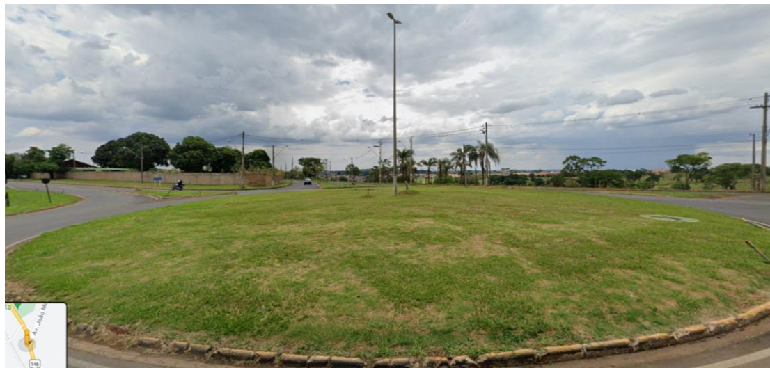
PTZ 21: Av. Tancredo Neves / Av. João Moreira Sales Poste: 9 metros Suporte prolongador: 2 metros Referência: na rotatória
