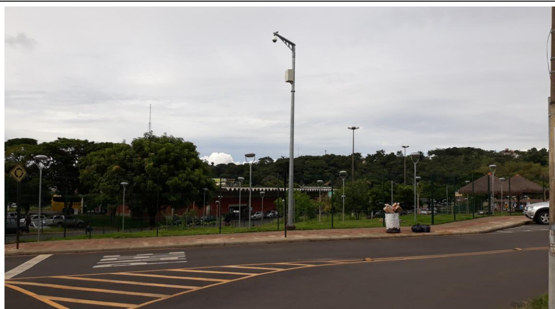
PTZ 52: Praça Antônio Alves da Costa Poste: 11 metros Suporte prolongador: 4 metros Referência: Terminal Rodoviário
