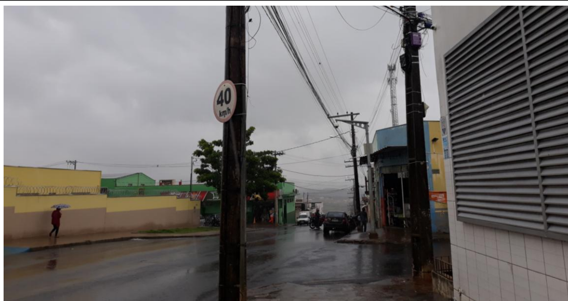
PTZ 53: Rua Sebastião Ferreira Pinto / Tonico Alonso Poste: 6 metros Suporte prolongador: 4 metros Referência: calçada (próxima do Supermercado Irmãos Paula)
