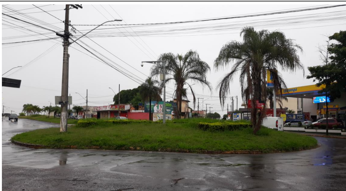
PTZ 13: Av. Washington Barcelos / Av. Doutor Danilo Cunha / Av. Pedro P. Lemos Poste: Até 6 metros Suporte prolongador: 2 metros Referência: centro da rotatória
