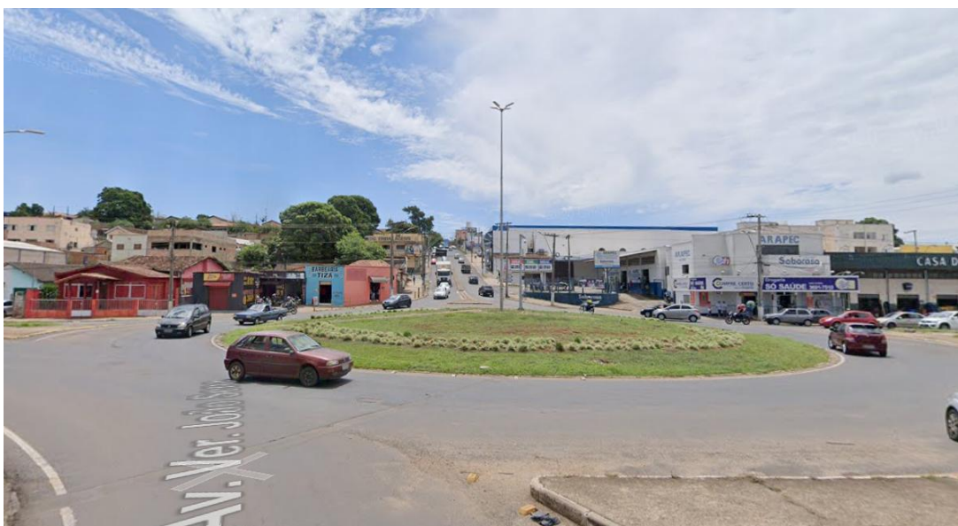
PTZ 14: Av. João Paulo II / Av. João Sena / Av. Vereador João Sena Poste: 11 metros Suporte prolongador: 2 metros Referência: centro da rotatória
