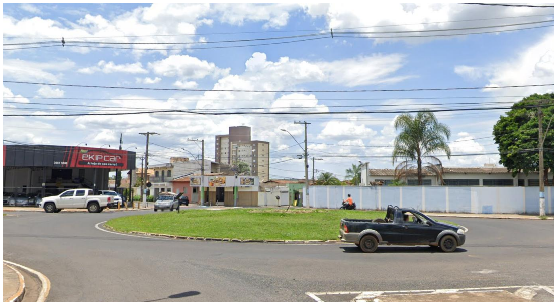
PTZ 25: Av. Imbiara / Edmar Cunha / Luiz Colombo Poste: 9 metros Suporte prolongador: 2 metros Referência: rotatória da Escola Vasco Santos
