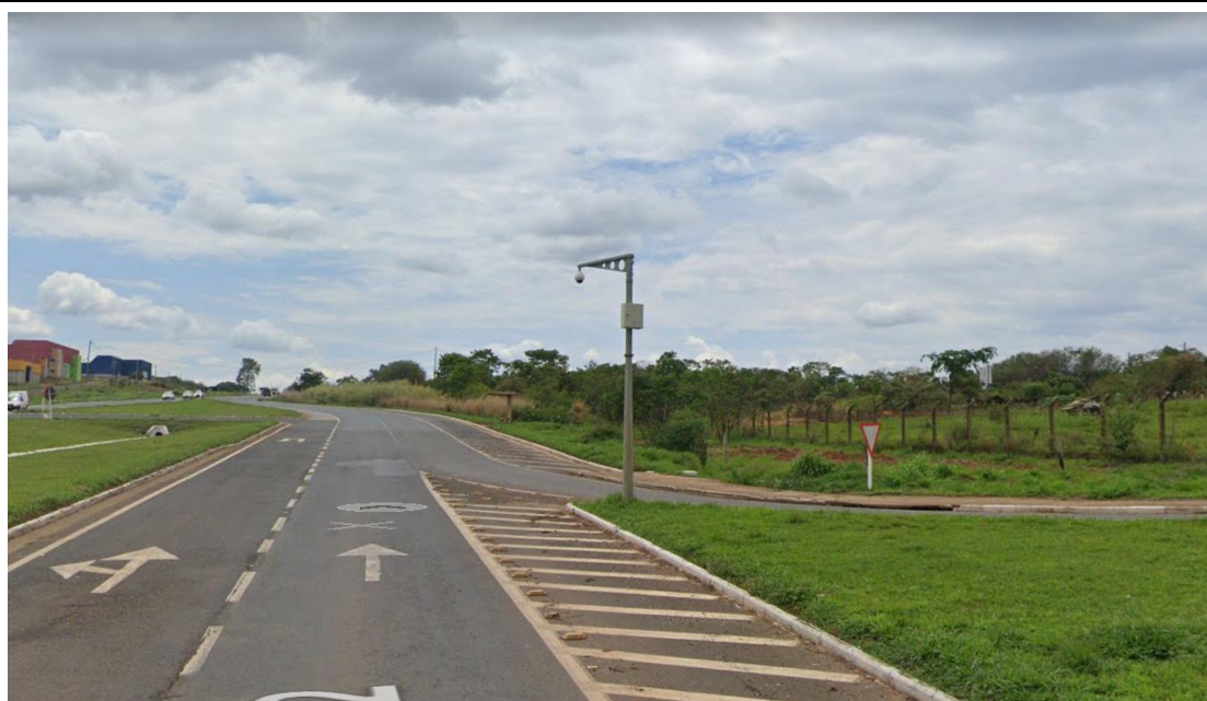
FIXA 71: Distrito industrial Poste: 6 metros Suporte prolongador: 5 metros Referência: entrada do complexo
