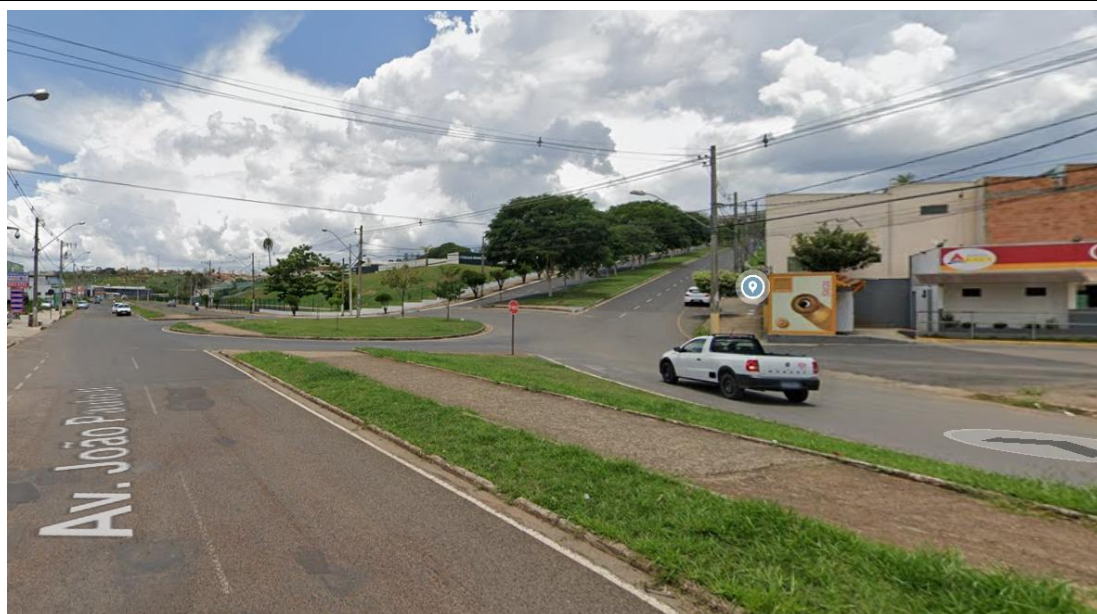
PTZ 17: Av. João Paulo II / Av. Rosália Isaura de Araújo Poste: 9 metros Suporte prolongador: 2 metros Referência: canteiro central
