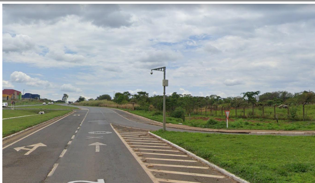
FIXA 72: Distrito industrial Poste: Utilizar mesmo da FIXA 71 Suporte prolongador: 5 metros Referência: entrada do complexo
