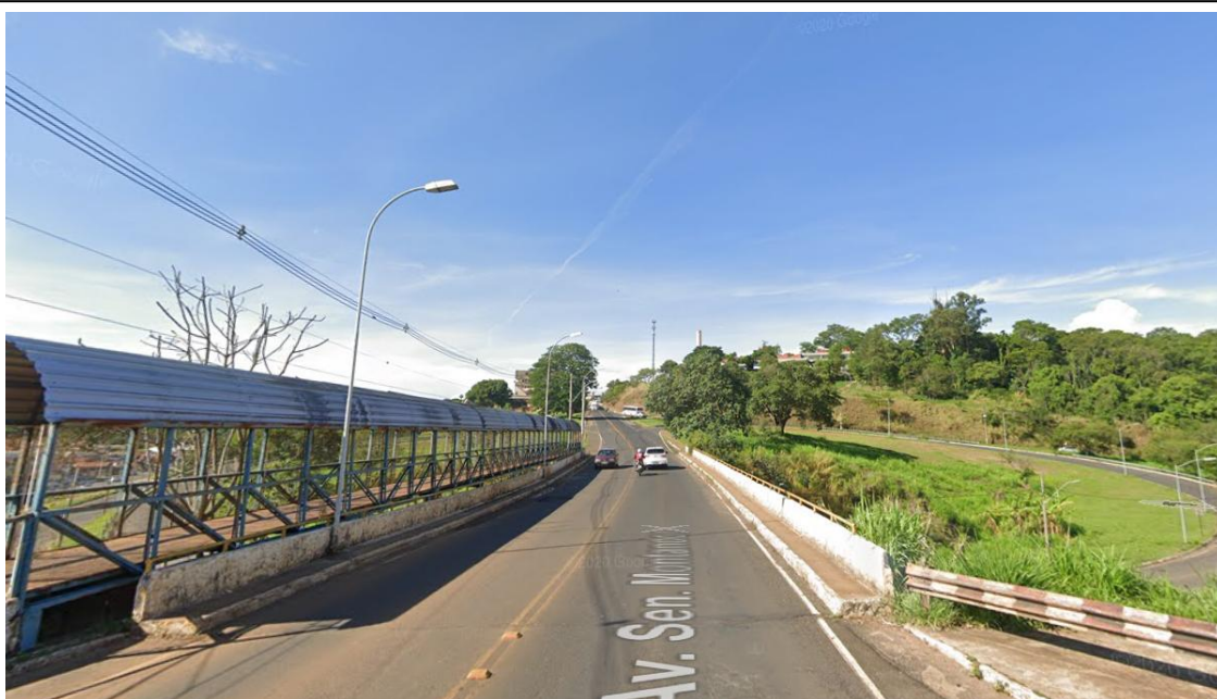
PTZ 62: Av. Senador Montandon Poste: 9 metros Suporte prolongador: 2 metros Referência: na calçada próximo a defesa metálica
