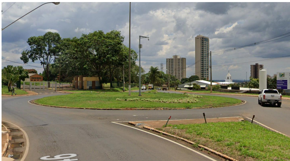
PTZ 37: Av. Tancredo Neves Poste: 9 metros de altura Suporte prolongador: 2 metros Referência: centro da rotatória (antigo Fórum)
