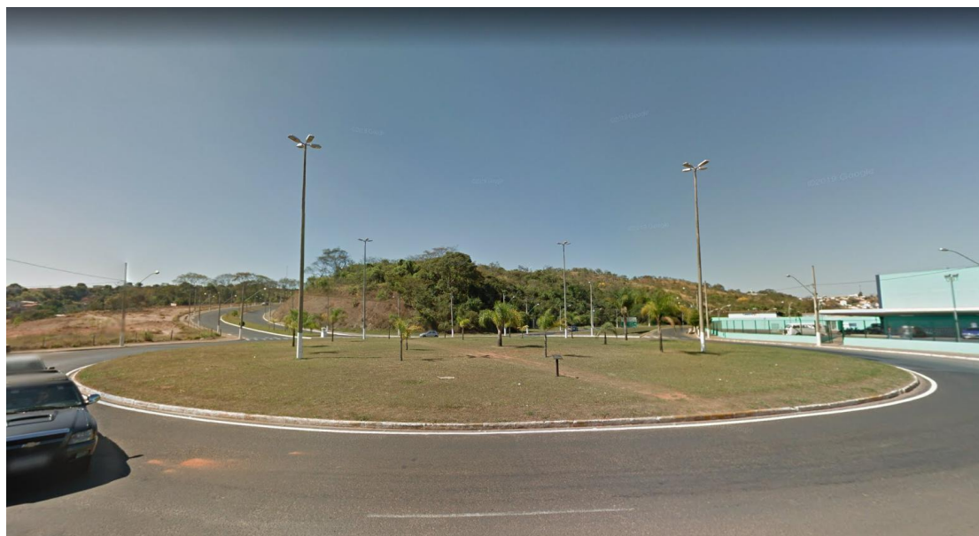
PTZ 29: Av. João Paulo II/ Dâmaso Drumond / Danilo Cunha / Rosalvo S. Poste: 9 metros Suporte prolongador: 2 metros Referência: rotatório (supermercado Bernardão)
