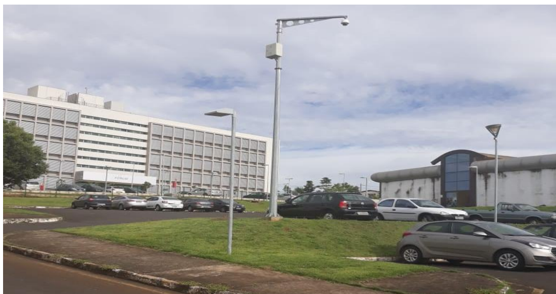
PTZ 34: Centro Administrativo Poste: 6 metros Suporte prolongador: 2 metros Referência: entre Secretaria de Obras e Licitação
