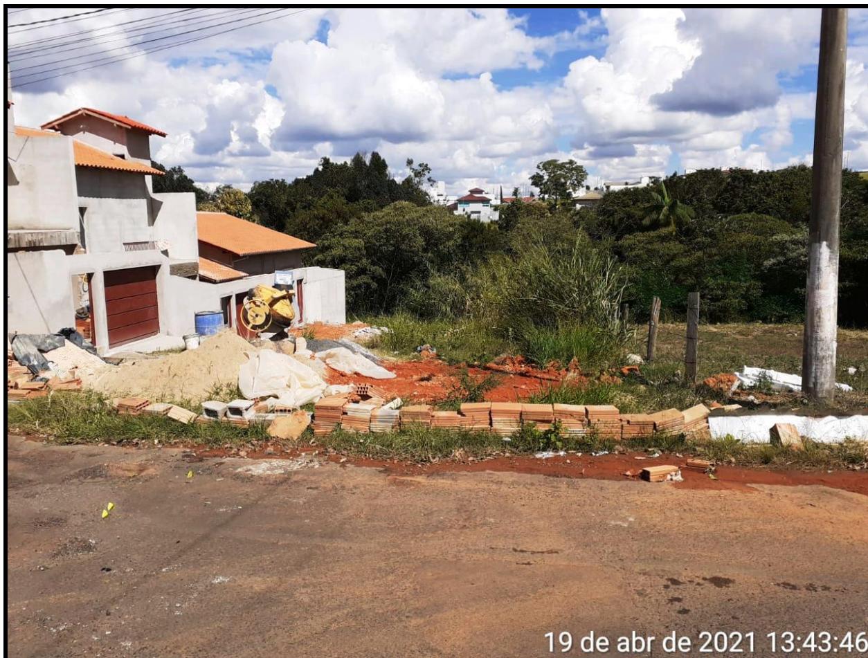
Implantação de via: Rua Ademar Rodrigues do Vale
