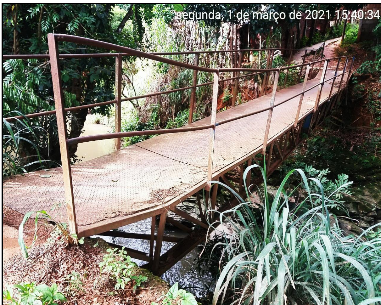
Passarela sobre o córrego Grande
